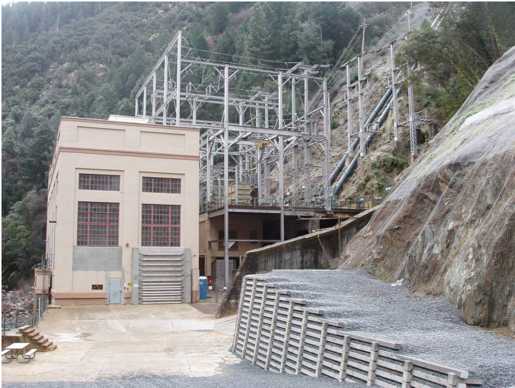
Photo B22 – El Dorado Powerhouse
