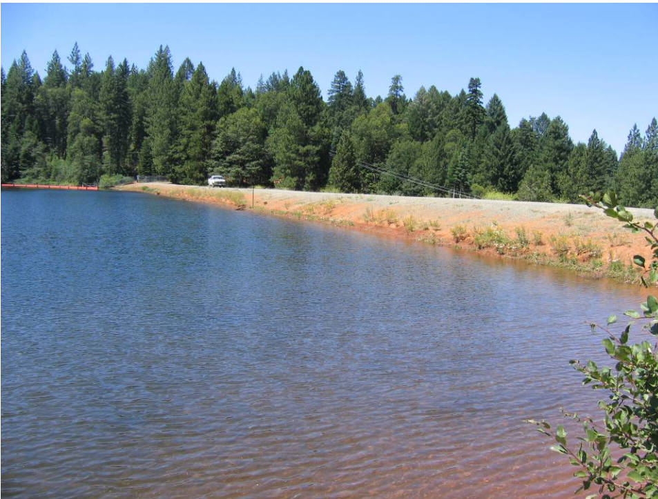
Photograph B-28. El Dorado Forebay Dam.
