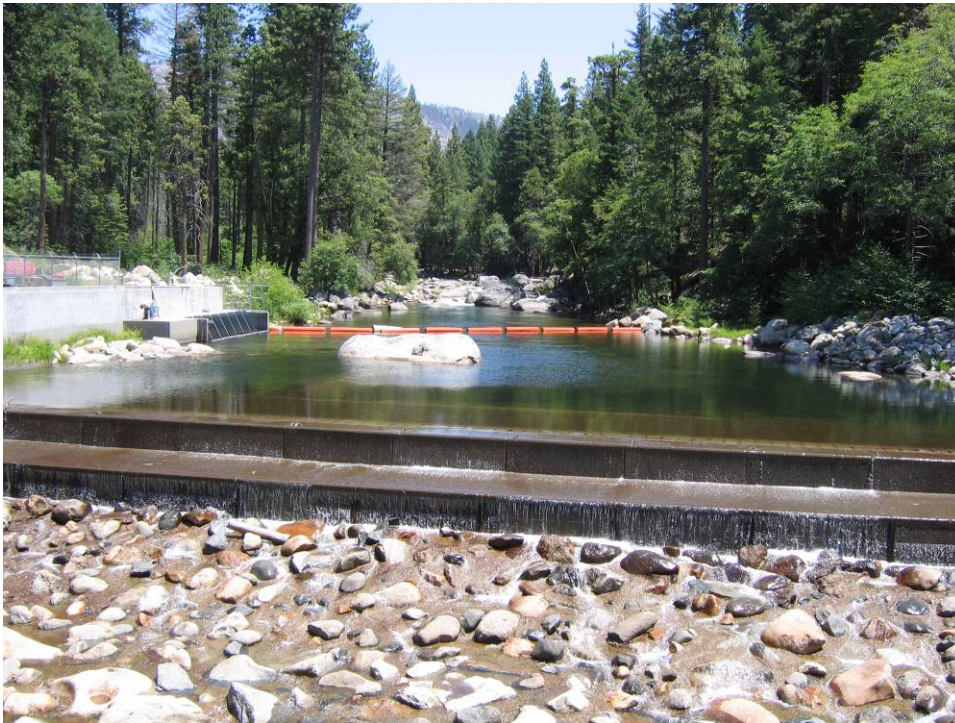
Photograph B-25. El Dorado Diversion Dam.
